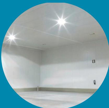
Los **paneles aislantes** para grandes construcciones y recintos frigoríficos incorporan un sistema de unión automático formado por un prefabricado estructural y aislante de poliuretano inyectado en molde cerrado, recubierto por dos chapas de acero galvanizado y lacado de gran resistencia.
